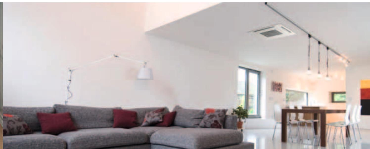
Das 4-Wege Kassettengerät verschwindet bis auf die Blende komplett in der abgehängten Decke. Das Gerät bietet durch seine vier Lüftungswege eine individuelle Klimatisierung einer Zone.
